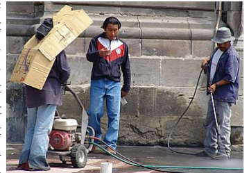
Hoge druk schoonmaakwerkzaamheden op het plein van de Kathedraal.
